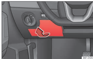
Abb. 160 Auf der Fahrerseite in der Schalttafel: Abdeckung des Sicherungskastens.
